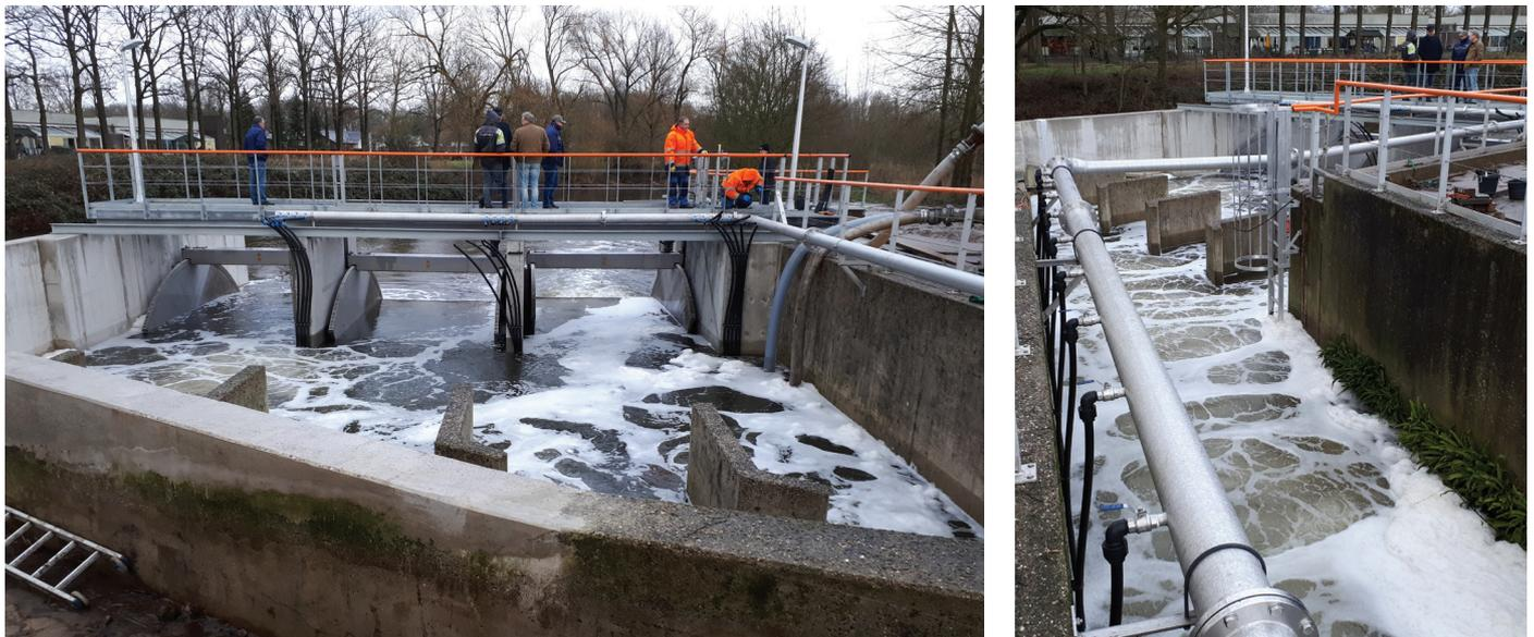
**ABBILDUNG 7.** Der Belüftungskanal der Kläranlage Eindhoven ist in Betrieb, da er die Sauerstoffqualität des Abwassers vor dem Wiedereintritt in die Dommel verbessert. Links: Blick auf den verstellbaren Damm am Ausgang des Belüftungskanals. Rechts: Ansicht des Belüftungskanals vom Einlass aus.
