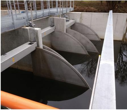
**ABBILDUNG 3.** Blick auf den verstellbaren Damm am Ausgang des Belüftungskanals.
